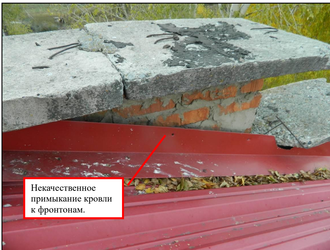
Рис. 10 Фрагмент кровли в осях «1/А-Г»
