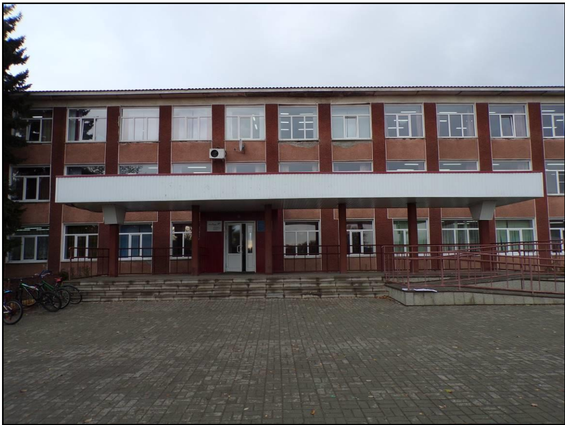
Фрагмент фасада в осях «1-12»
