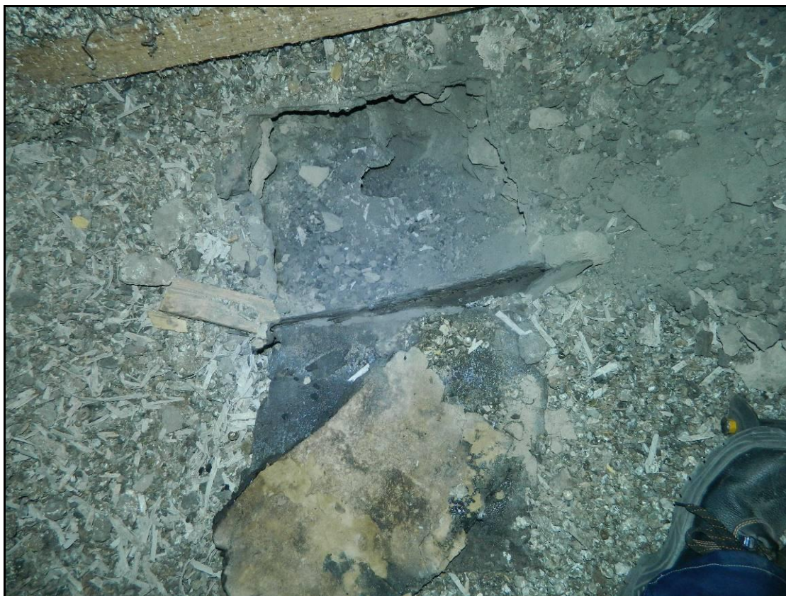
Рис. 6 Фрагмент вскрытия совмещенного покрытия в осях «1-12/А-Г»
