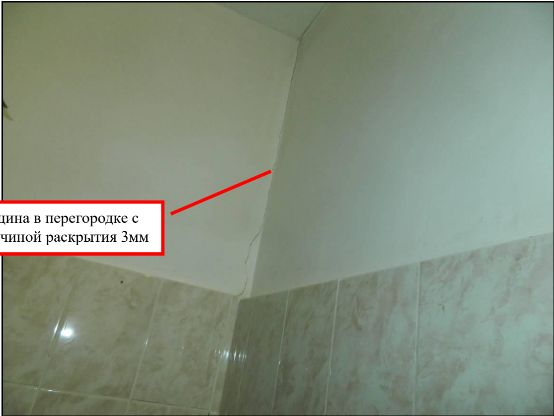
Рис. 27 Фрагмент помещения в осях «2-5/Д-Ж»
