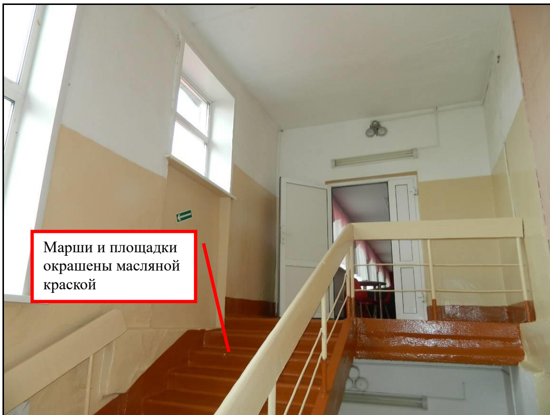
Рис. 15 Лестничная клетка в осях «2-4/В-Г»
