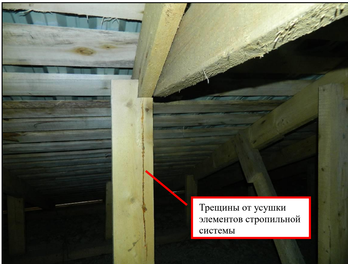
Рис. 7 Фрагмент крыши в осях «1-12/А-Г»
