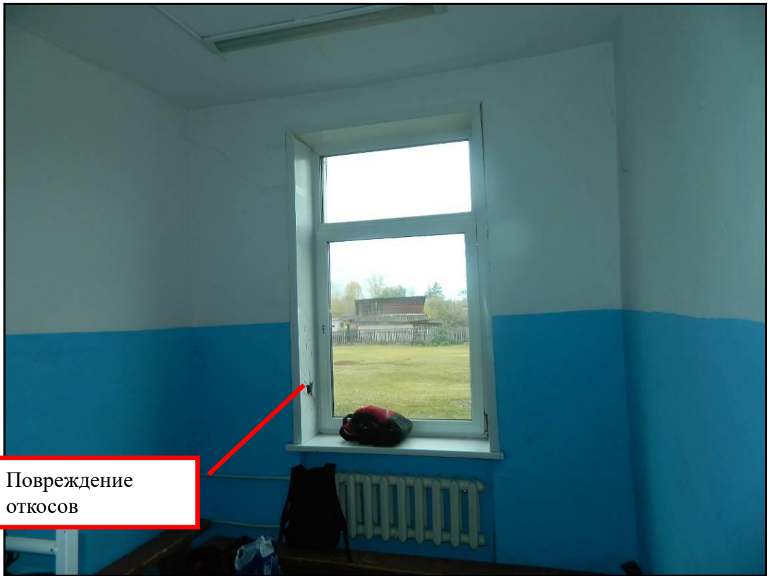
Рис. 35 Фрагмент оконных блоков
