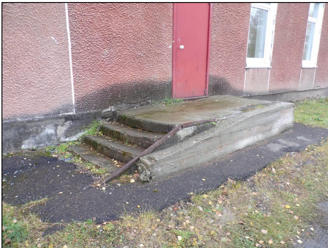
Рис. 41 Входной узел в осях «7/Ж»
