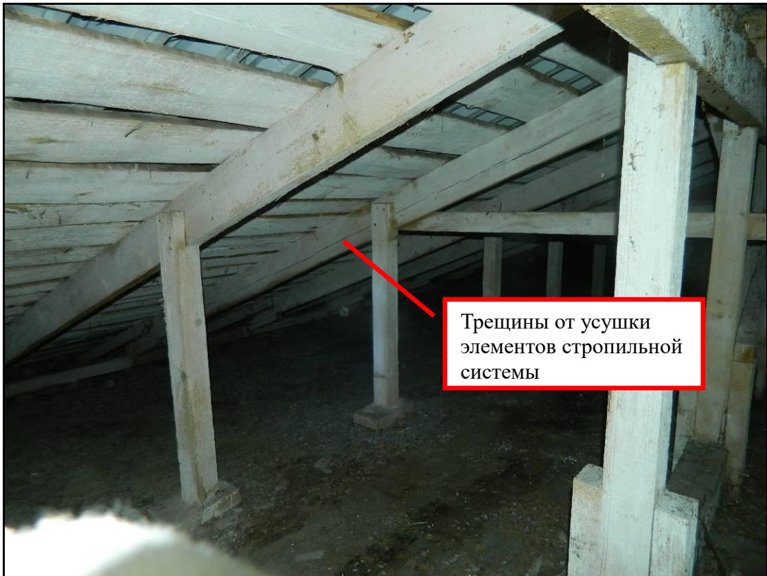
Рис. 30 Фрагмент крыши в осях «2-11/Д-Ж»
