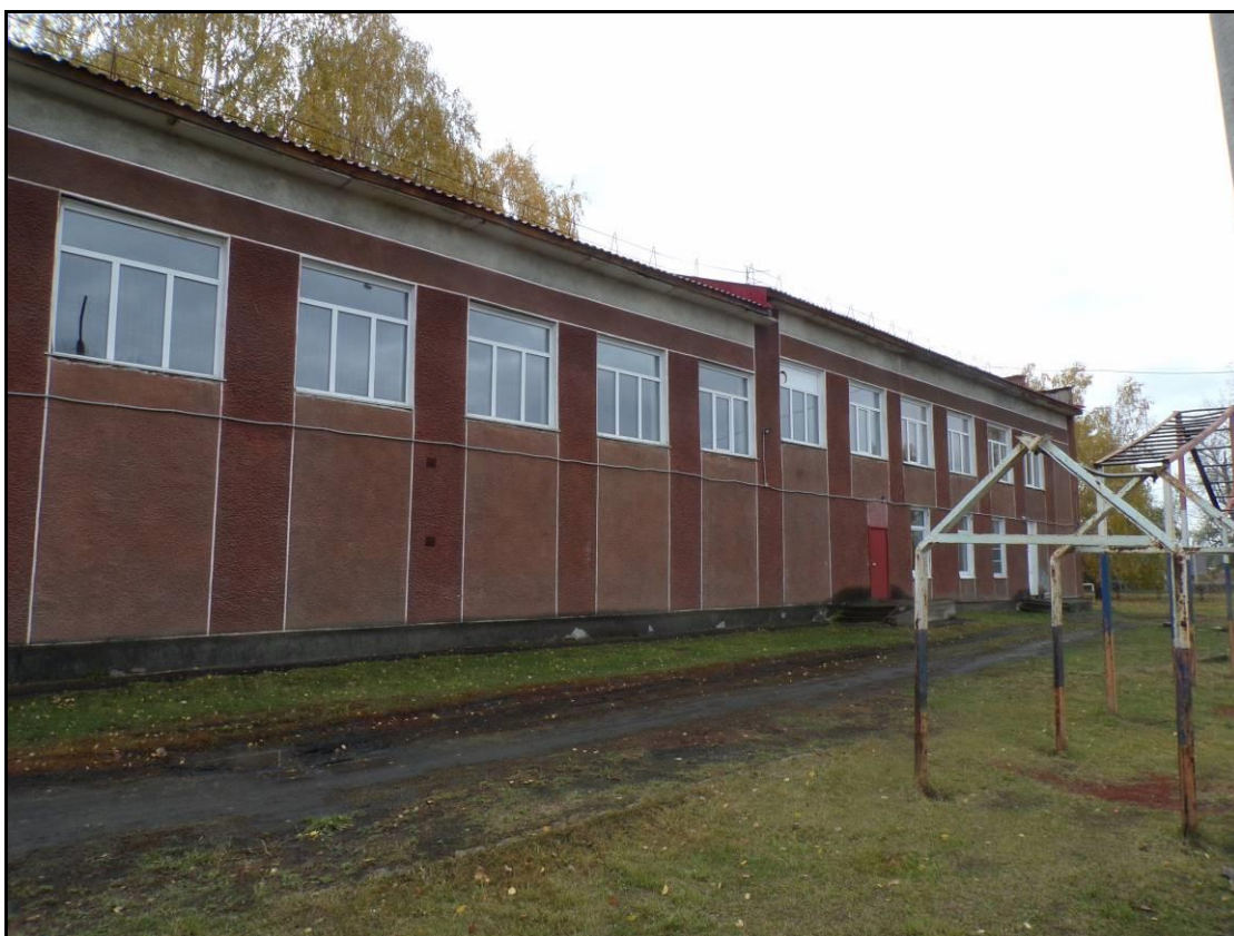
Фрагмент фасада в осях «11-2/Ж»
