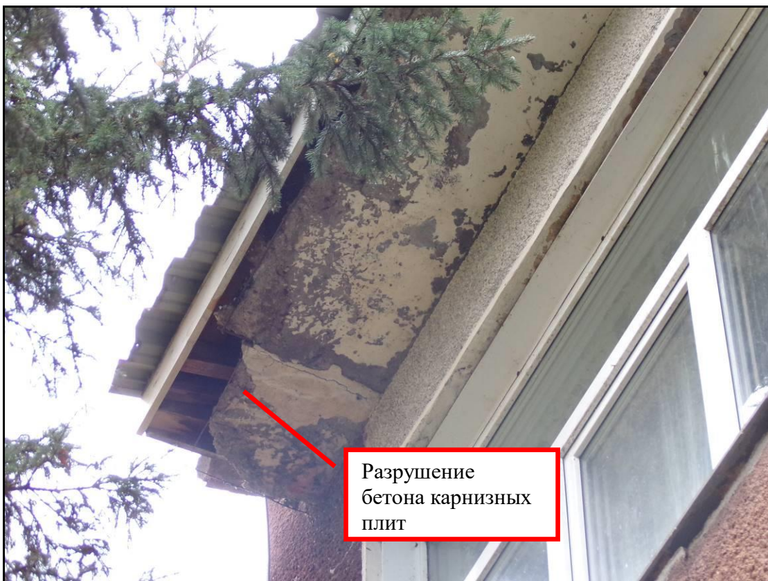
Рис. 8 Фрагмент фасада в осях «1/А»
