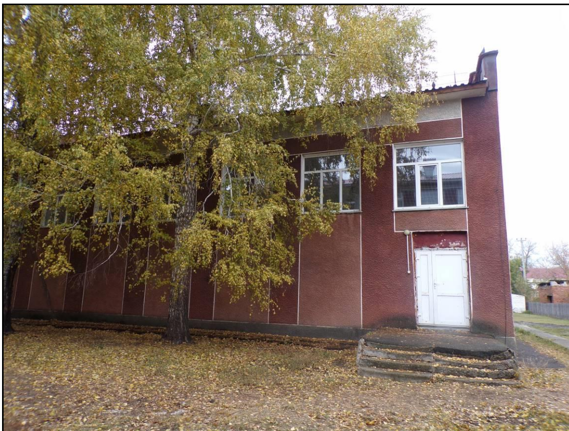
Фрагмент фасада в осях «6-11/Д»
