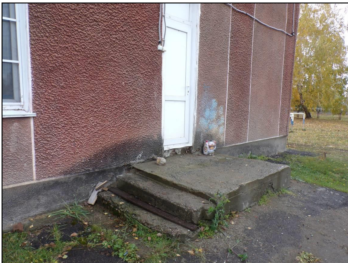
Рис. 42 Входной узел в осях «7-2/Ж»
