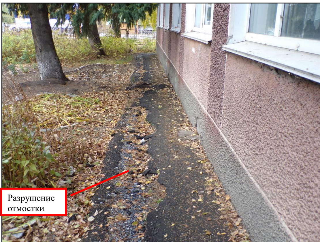
Рис. 24 Фрагмент отмостки
