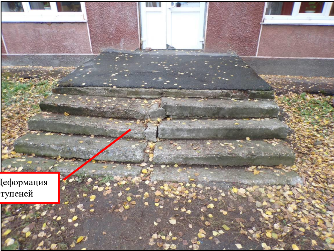
Рис. 38 Входной узел в осях «6/Г-Д»
