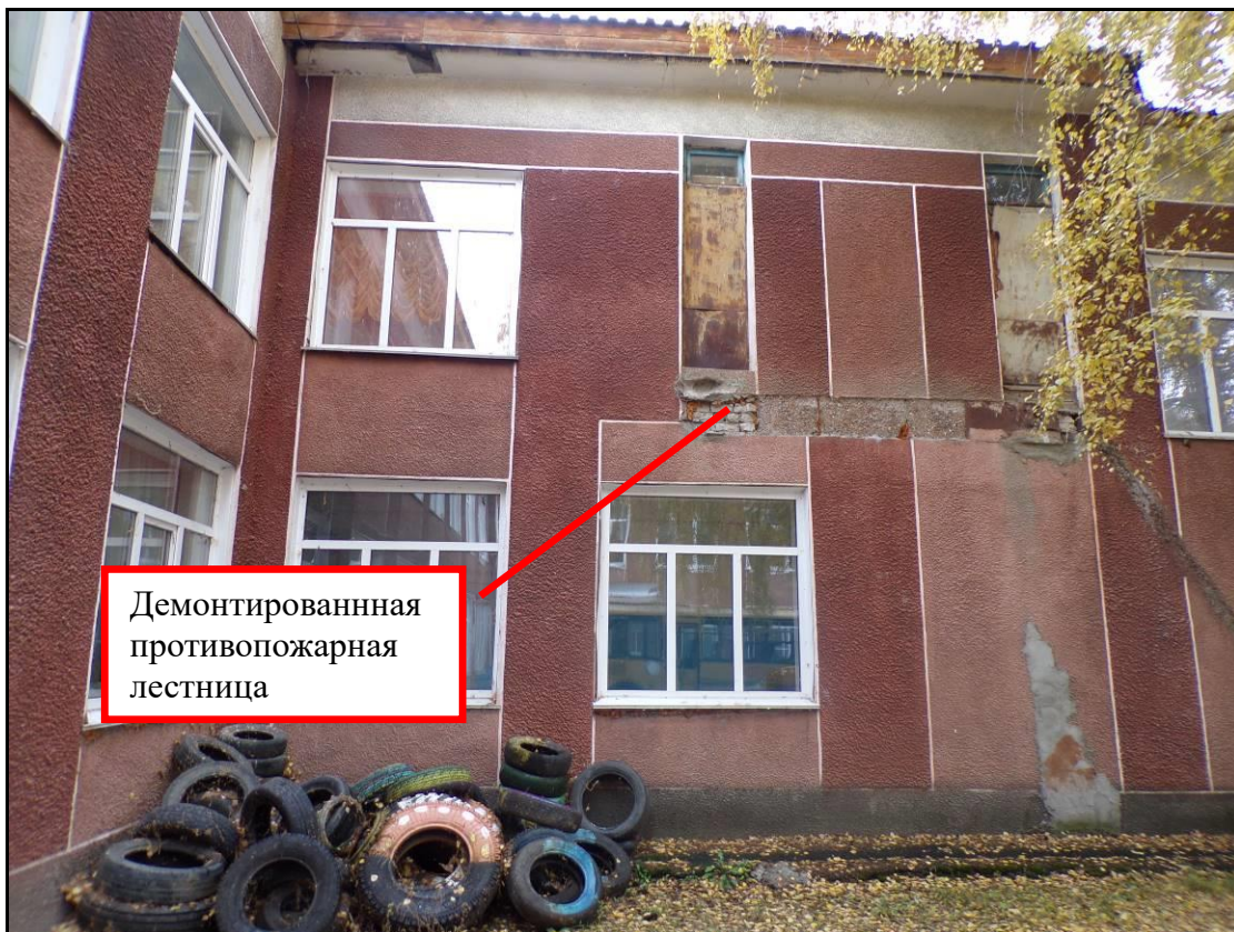
Рис. 39 Фрагмент противопожарной лестницы в осях «б-11/Д»
