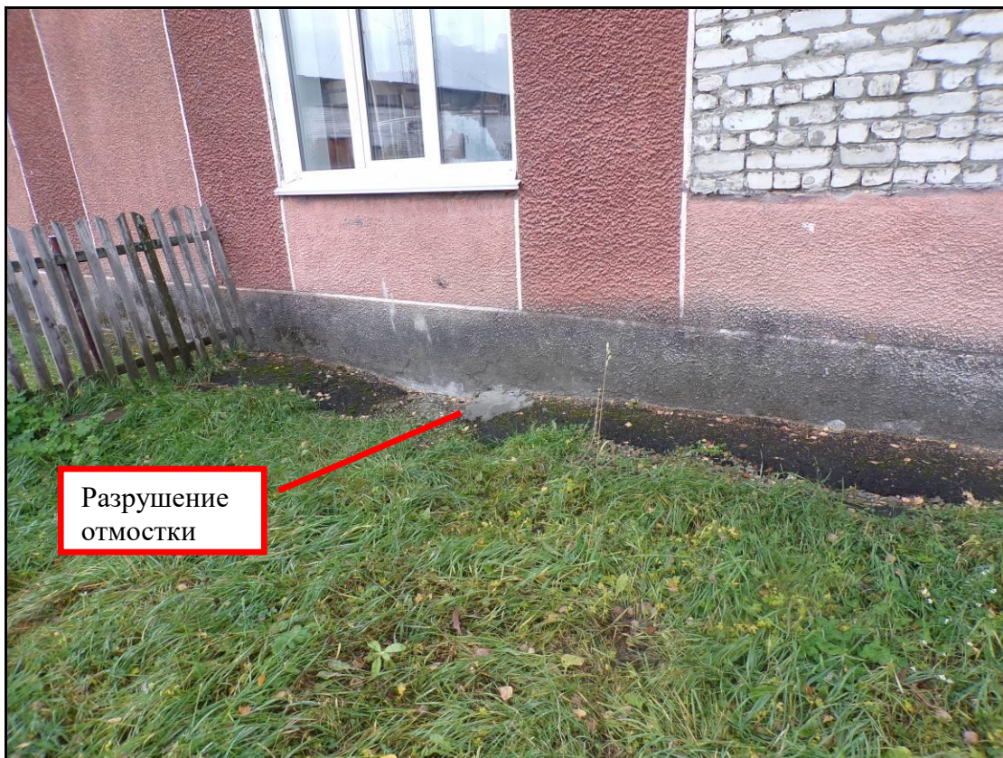
Рис. 23 Фрагмент отмостки
