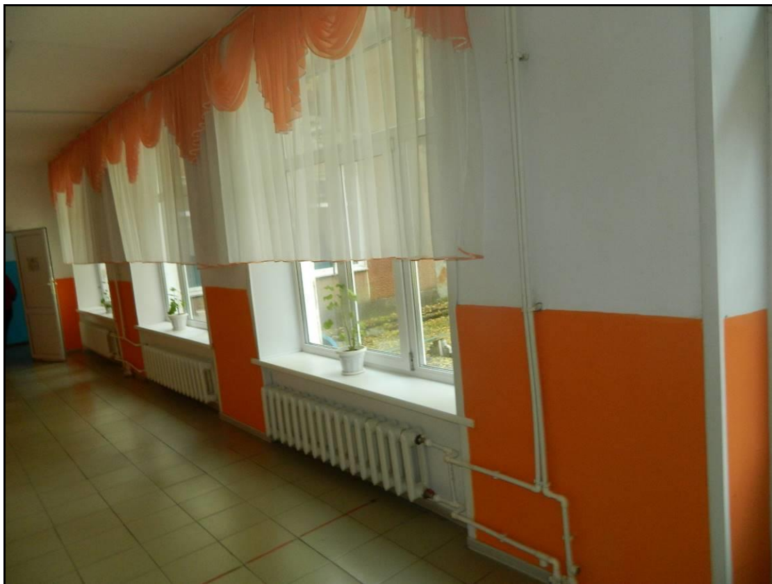
Рис. 44 Радиаторы отопления
